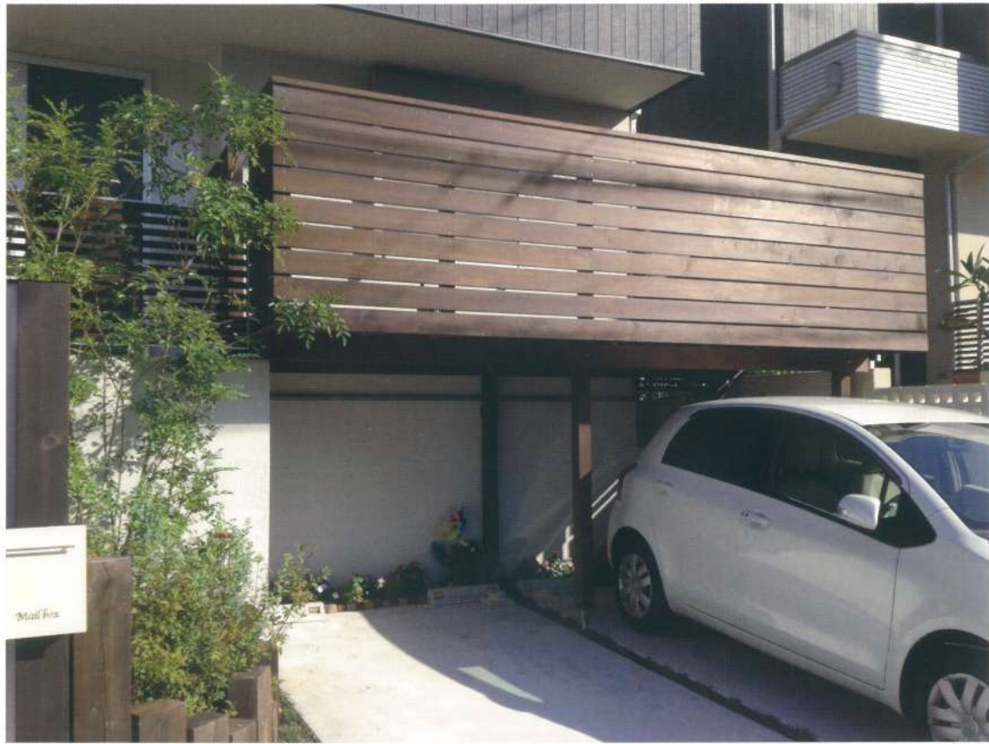
■ バルコニーデッキ
